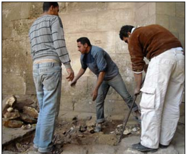
doc. 15 : TP2 : Dismantling the pavement
